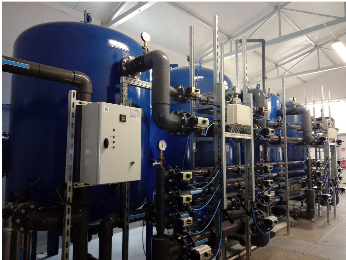
Rysunek. Stacja uzdatniania wody w Cielądku – I etap realizacji umowy w ramach dofinansowania EFR na rzecz Rozwoju Obszarów Wiejskich na lata 2014-2020.
