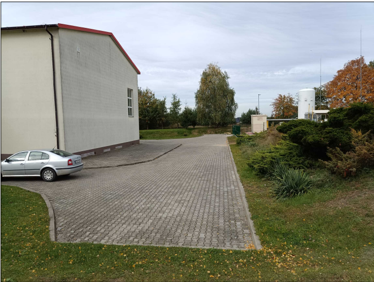
FOT. 5 WIDOK NA ISTNIEJĄCE UTWARDZENIE POMIĘDZY BUDYNKIEM SZKOŁY A ISTNIEJĄCYM BOISKIEM .
